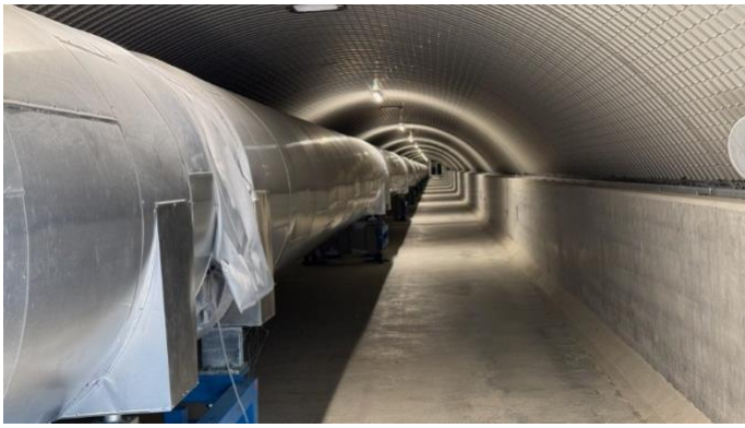
Braccio Nord, con un particolare del punto di giunzione
