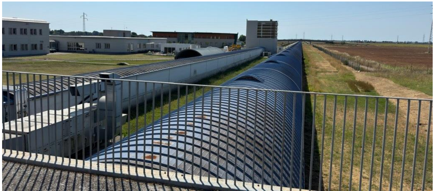
Braccio Ovest (a destra), con la “mode cleaner cavity” (a sinistra)
